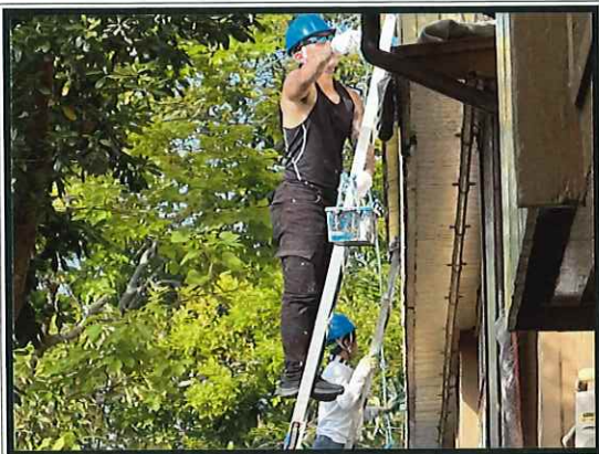
施設屋根・外壁塗装風景 出来る限り仲間達で修繕を行います
